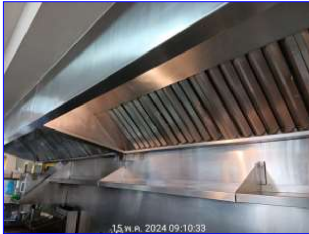
รูปที่ 2.19 Hood และระบบระบายอากาศในห้องพัก
